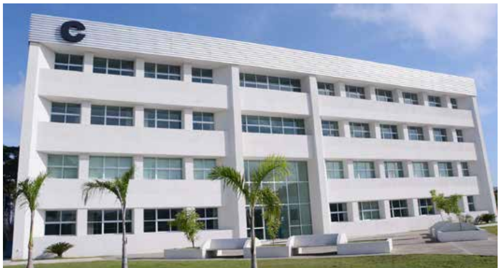
Moderno edificio inaugurado en la División de Ciencias Sociales y Humanidades.
